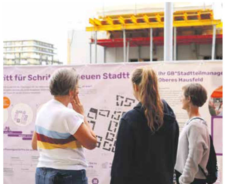
Ein neuer Stadtteil im Entstehen: Vor Ort kann man sich jederzeit informieren.
