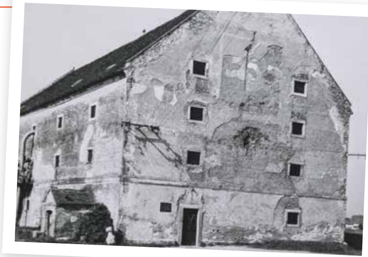
Schüttkasten Essling (seit ca. 1720) - Getreidespeicher.
