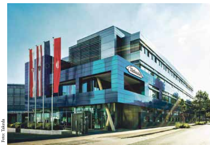
Erstes zertifiziertes Industrie Green Building in Gold bei Takeda in Wien
