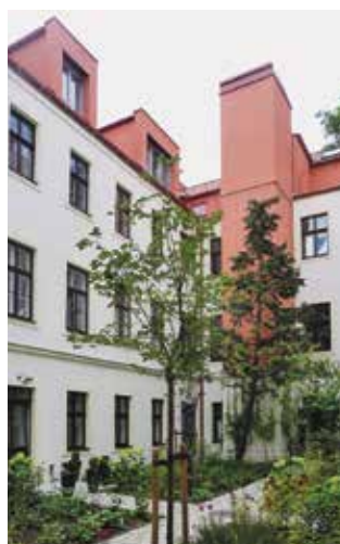
Im Rahmen der Haussanierung im 9. Bezirk wurde der Innenhof neu gestaltet.
