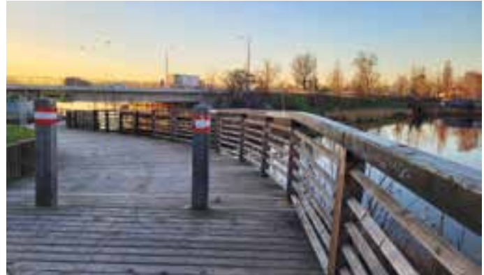
Der Kagraner Steg wird noch bis Ende Mai saniert. Die Holzkonstruktion wird gegen eine Glasfaser-Kunststoff-Lösung getauscht. Fotos: Strumberger-Sellner
